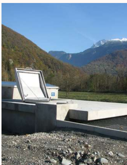
← Puits de la Romanche
