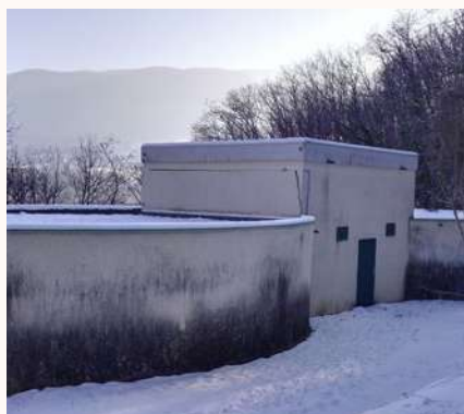
← Réservoir Champa - Le Gua
